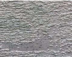
B. K čištění zateplené fasády a opravě závad její soudržnosti se přistupuje až v době, kdy „už se na to nedá dívat“. To je obvykle po osmi a více letech od realizace zateplení. Pak je nutno většinou řešit více problémů:
